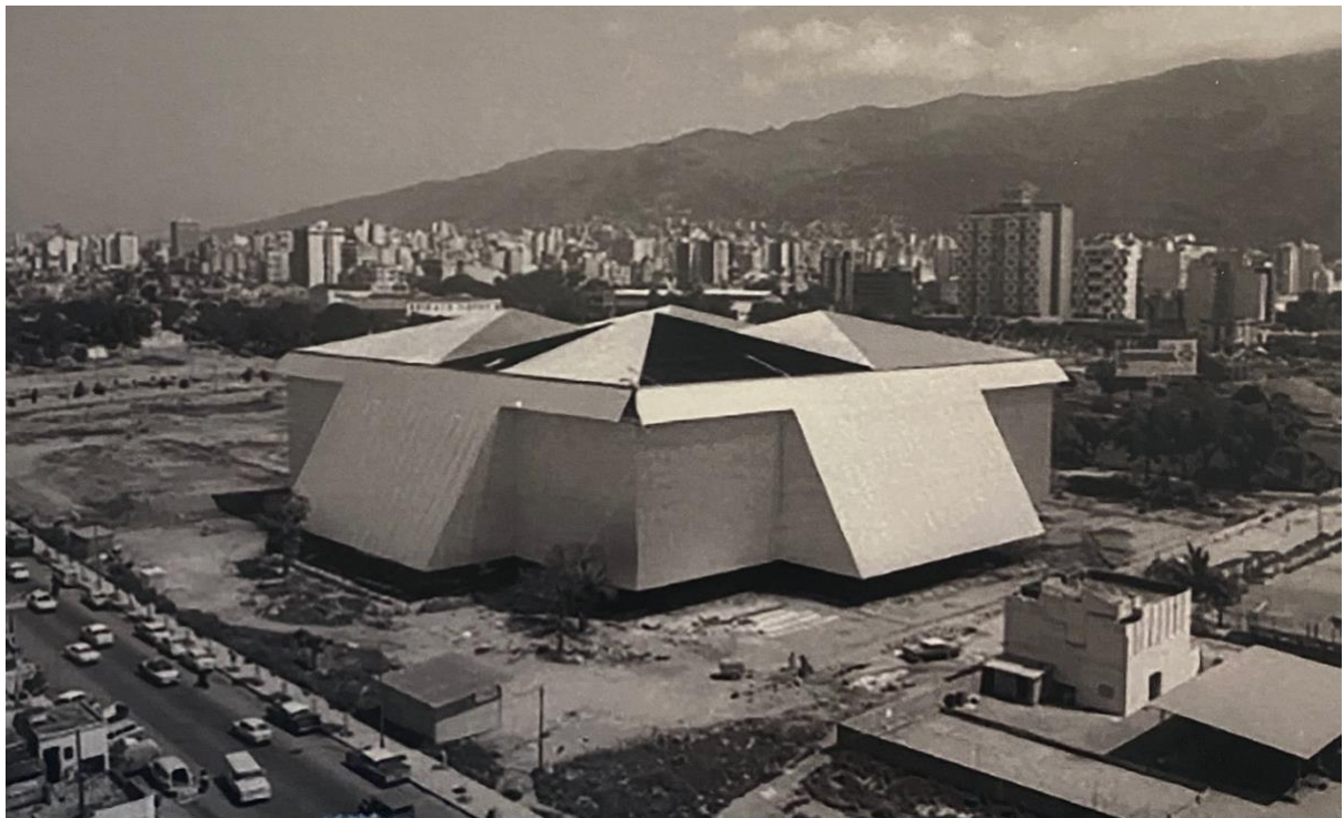
Figure 3. Juan Pedro Posani, Ciudad Dispositivo (“City Device”), 1967. Exterior view, El Conde, Caracas.
